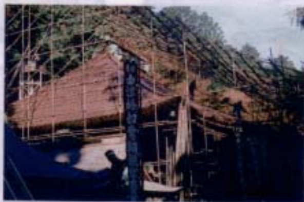
慎重に屋根解体 新しい屋根がのそく
